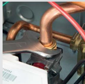
Rimozione del sistema di serraggio della tubazione
