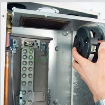
Rimozione del sistema di combustione completo
