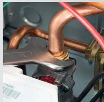
Rimozione del sistema di serraggio della tubazione
