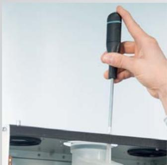
Rimozione vite blocco collettore fumi
