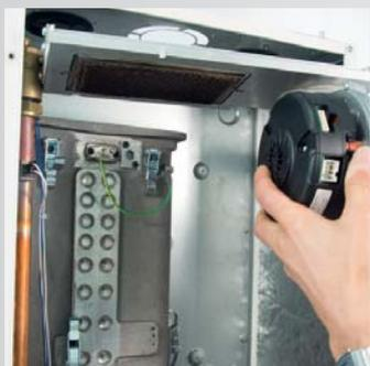
Rimozione del sistema di combustione completo
